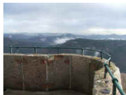
Vom Luitpoldturm nach Osten
